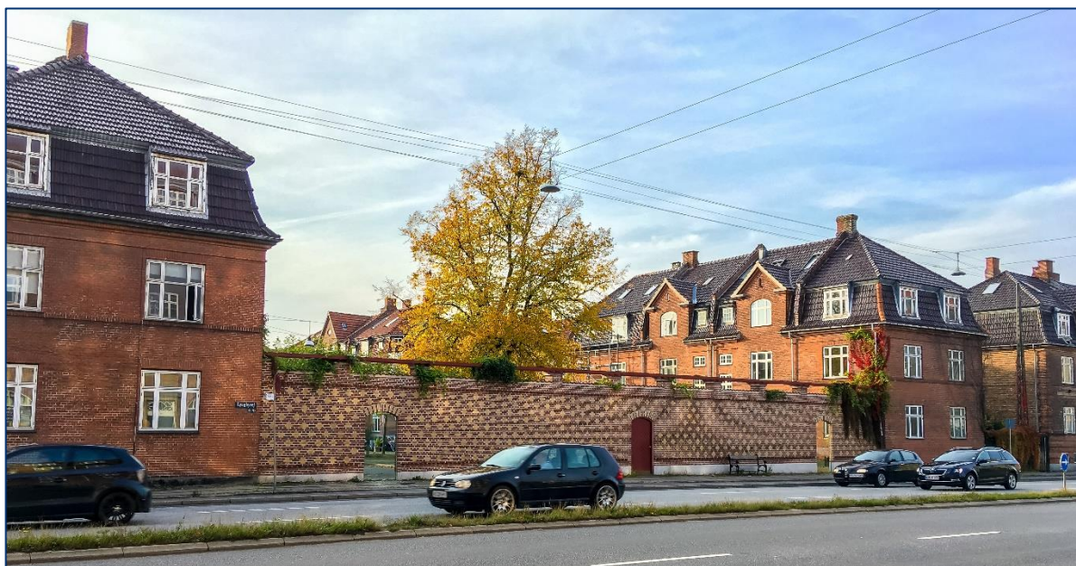
Figur 24. Her har en grundejerforening bygget en støjskærm i åbningen mellem to husrækker. Resultatet er et støjbeskyttet område bag skærmen (Lyngbyvej, København)
