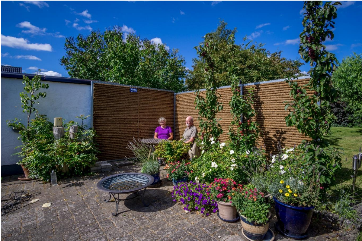
Figur 21. Et støjhegn kan skabe en støjafskærmet krog eller terrasse. Den støjdæmpende virkning kan opleves i et mindre område lige op af hegnet (fra en forsøgsopstilling i en have i Glostrup).
