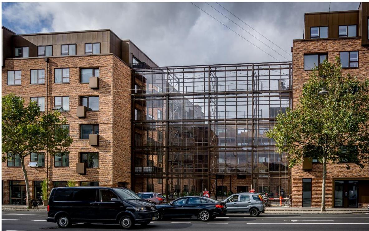
Figur 17. I denne nye bebyggelse, har man anvendt en støjskærm i åbningen mellem bygningerne for at opnå et lavt støjniveau i bebyggelsens gårdmiljø. I facaden mod vejen er der anvendt særligt støjdæmpende vinduesløsninger (Gl. Køge Landevej, København).
