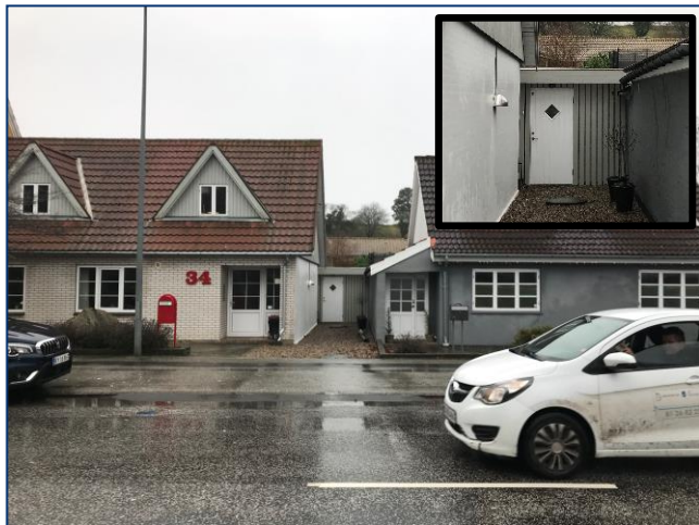
Figur 23. Boligerne skærmer for støjen, men der kommer støj ind gennem smøgen mellem de to huse. Ved at sætte et hegn (her også med en dør) i smøgen, er støjen i baghaven dæmpet mærkbart.
