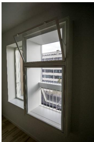
Figur 18. Støjdæmpende multifunktionsvindue (billederne til venstre og i midten). Støjen dæmpes på vejen gennem åbningen for nedenunder (udendørs) til åbningen for oven (indendørs). Til højre er vist en lydskodde, som er monteret foran et eksisterende vindue. Den dæmper støjen, men giver også adgang for frisk luft. Den kan desuden mørkelægge et rum, hvis det ønskes.
