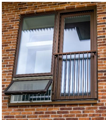
Figur 18. Støjdæmpende multifunktionsvindue (billederne til venstre og i midten). Støjen dæmpes på vejen gennem åbningen for nedenunder (udendørs) til åbningen for oven (indendørs). Til højre er vist en lydskodde, som er monteret foran et eksisterende vindue. Den dæmper støjen, men giver også adgang for frisk luft. Den kan desuden mørkelægge et rum, hvis det ønskes.
