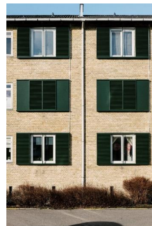
Figur 18. Støjdæmpende multifunktionsvindue (billederne til venstre og i midten). Støjen dæmpes på vejen gennem åbningen for nedenunder (udendørs) til åbningen for oven (indendørs). Til højre er vist en lydskodde, som er monteret foran et eksisterende vindue. Den dæmper støjen, men giver også adgang for frisk luft. Den kan desuden mørkelægge et rum, hvis det ønskes.
